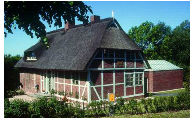
Das restaurierte Geburtshaus, Vorderdeich 9
