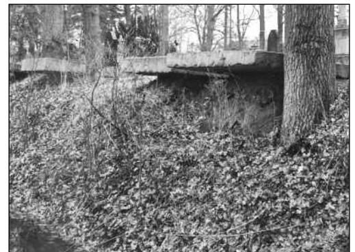
In Horizontallage lagerten die alten Grabplatten bis in die 1950er-Jahre schon viele Jahrzehnte; teilweise gebrochen, da sie nicht vollständig unterstützt waren!
