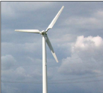
Im Bereich der Vierlande stehen etliche Windkraftanlagen
