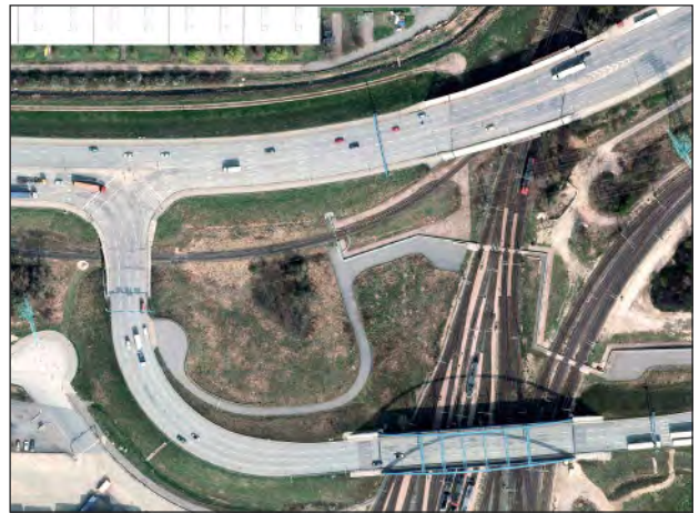
Die Finkenwerder Straße nach dem Umbau 2010
