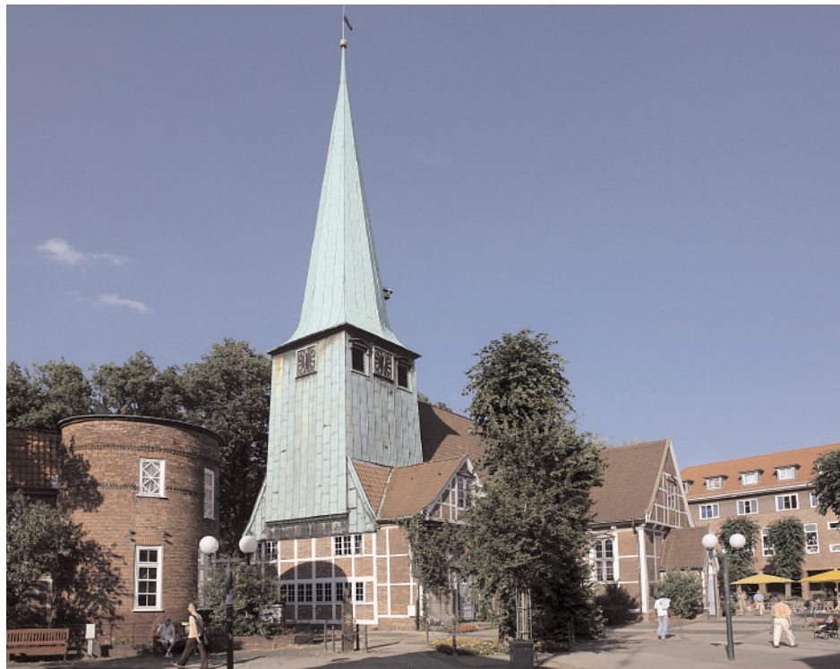
Neben der Kirche steht das um 1630 erbaute Hasse-Haus mit dem Rundturm von 1836. Rechts, im Hintergrund, das Gemeindehaus von 1930.
